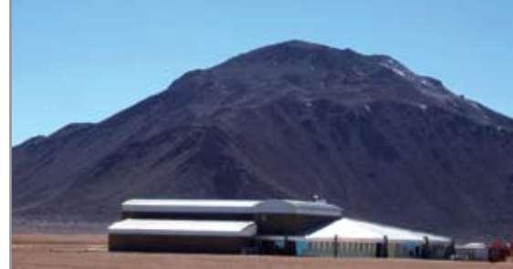
Le bâtiment de contrôle du réseau 5 000 mètres d'altitude avec Cerro Chajnantor au loin. (Photo par NRAO)
