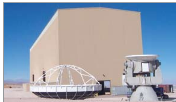
La première antenne de production est en cours de montage au niveau intermédiaire. (Photo par NRAO)
